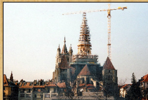
Cathédrale de Lausanne : restauration et traitement de la tour lanterne.
